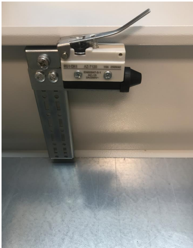
Рис.1-1 Установка датчика вскрытия в уличную станцию в металлическом корпусе.
